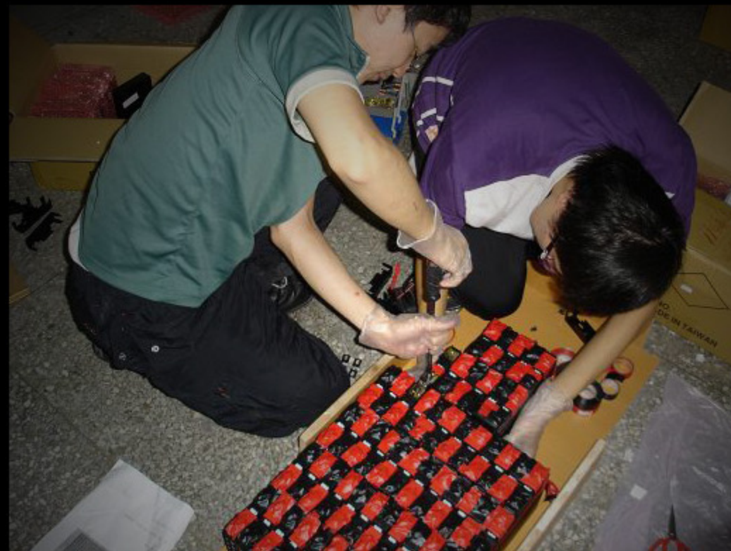
電池系統與變壓器
